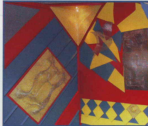
Dreidimensionale Metalltapete aus Formetal Ypsilon und farblich gestaltetem Vollblech. Verschiedene Objekte (Lumibär, Bobby-Car) wurden als Relief abgeformt und in die Wand integriert. Im Eck: Hohlkehle aus Y-Metall mit Downlight.
