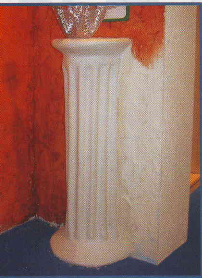
Eine mediterrane Säule, nicht massiv, sondern gebaut aus verformbaren Metallmatten und mit einer Spezialschicht (Verbundsystem Flexorit) überdeckt.
