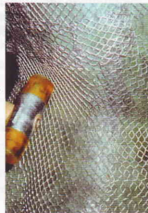
Ein Plastikhammer wird benutzt, um das Metall genau der Kontur anzupassen.
